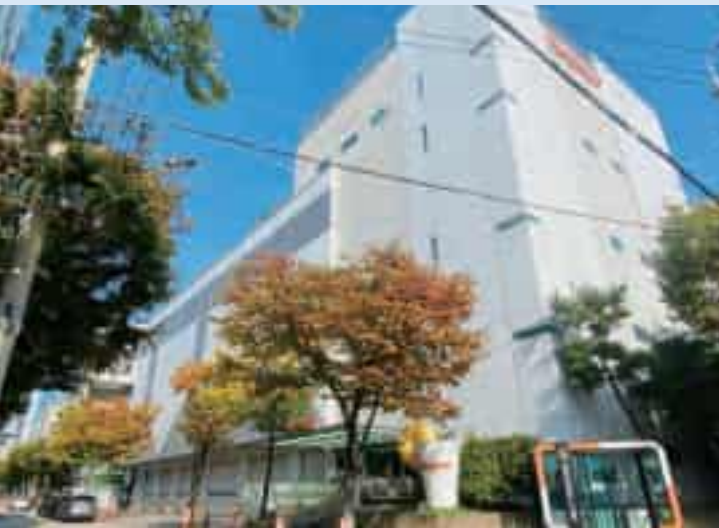
공장 용지(던킨도너츠 안양공장)
