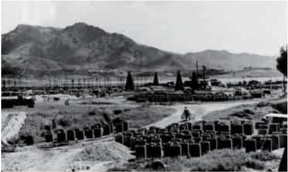
1962년 한국케이블공업 안양공장 건설 현장(LG전선 제공)
