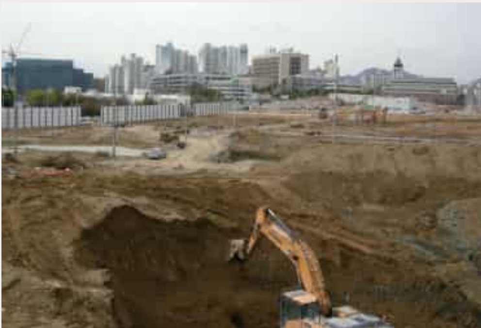
호원초등학교 주변 지구의 평촌어바인퍼스트아파트 건설 공사(2019년, 이정범 제공)
