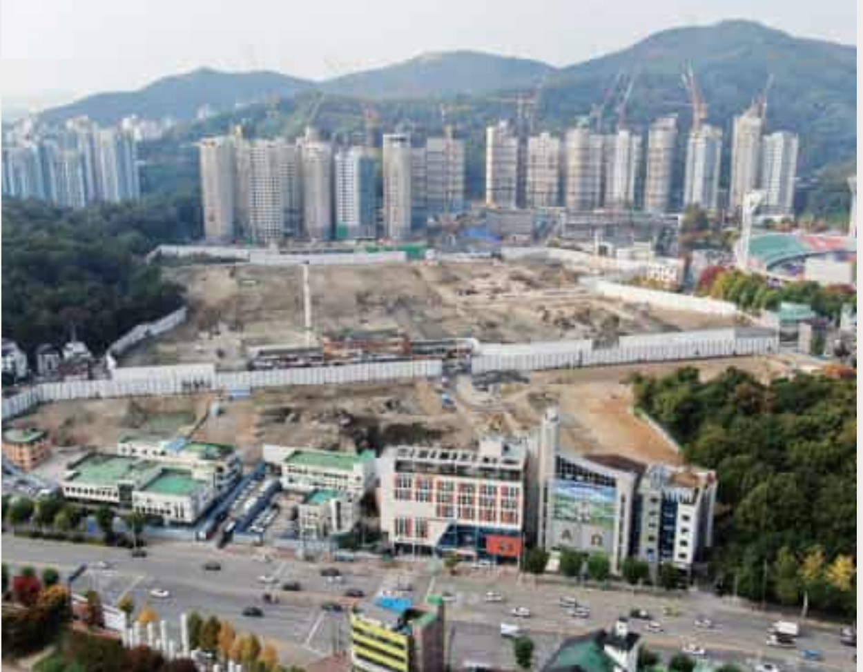
2023년 뉴타운맨션삼호아파트 재건축 현장 전경(안양시청 역사·포토갤러리 제공)
