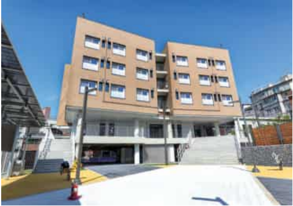
2016년 서울시 동작구청이 건립한 양녕 청년 공공임대주택(동작구청 제공) 동작구 산하 출자기관 '대한민국동작주식회사'의 기부금으로 만 원을 제외한 금액의 월세를 돌려받을 수 있어 '월세 만 원' 주택으로 화제를 모았다.
