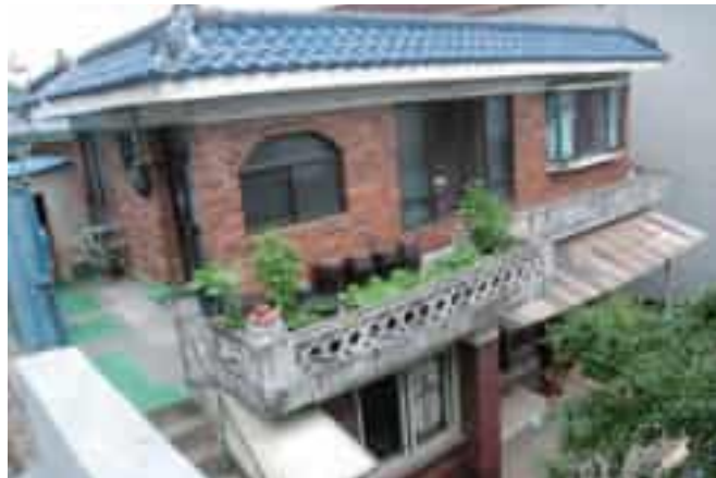
안양동 708-128번지 주택 외부 전경
