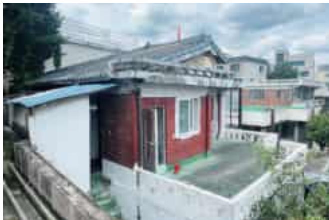
안양동 19-3번지 주택 외부 전경
