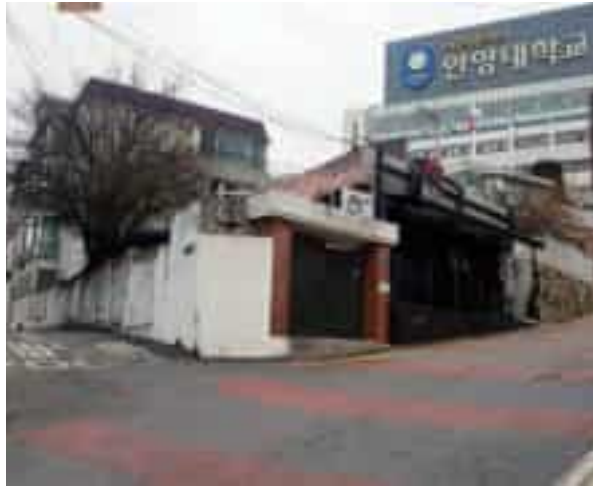
만안구 안양5동 일반주택 외부 전경
