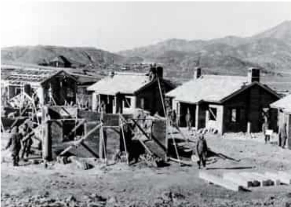
흙벽돌을 활용한 국민재건축주택 건설 현장 (United Nations Photo Library, 1954)
