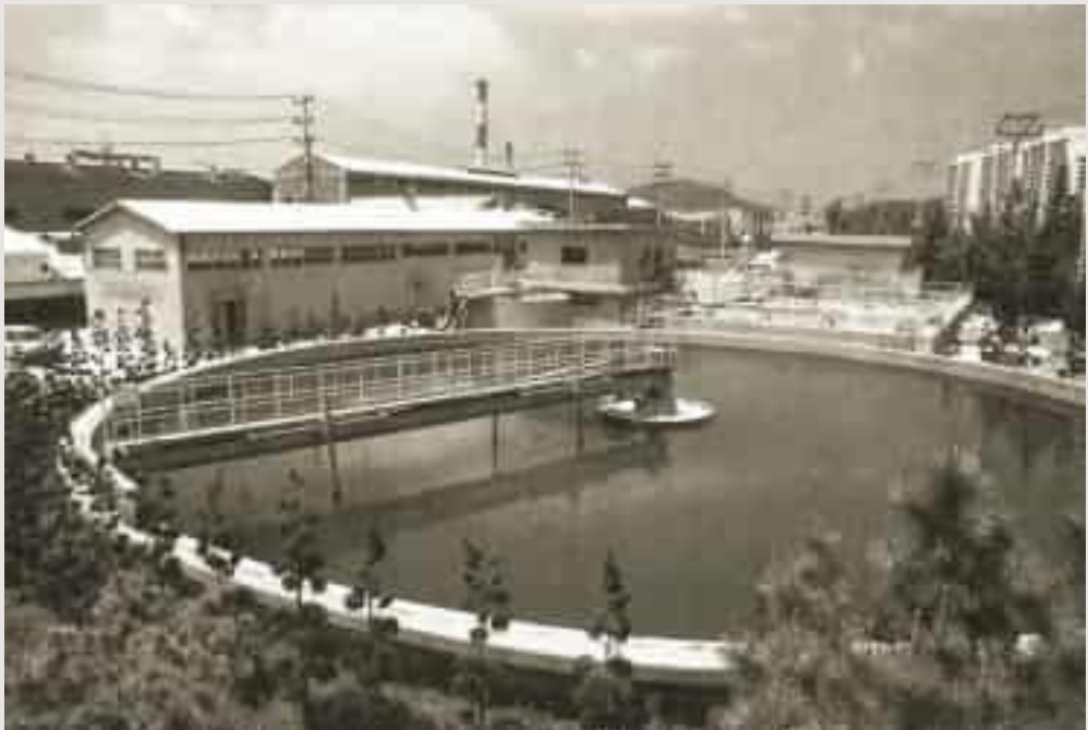
한국특수제지 안양공장 폐수처리시설(한국제지주식회사, 『한국제지 35년사』, 1993)
