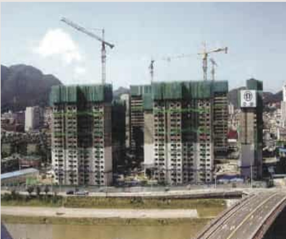
구시장지구 공동주택 건설 과정(대한주택공사, 『안양시 구시장마을 이야기』, 2005)
