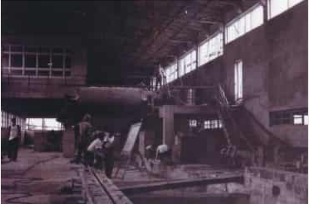
한국특수제지공업주식회사 안양공장 초지 1호기 설치 현장(한국제지주식회사, 『한국제지 35년사』, 1993)
