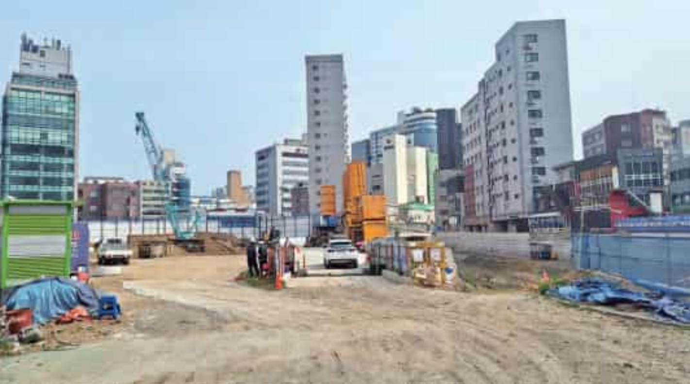
수암천 정비사업 공사 현장
