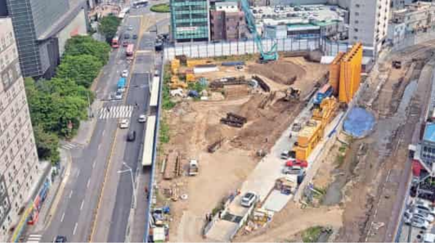
수암천 정비사업 공사 현장
