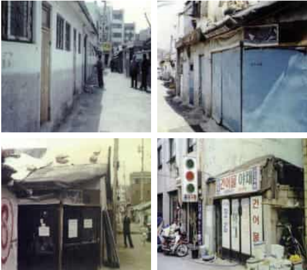
개발 직전 구시장 마을의 열악한 주거환경(대한주택공사, 『안양시 구시장마을 이야기』, 2005)
