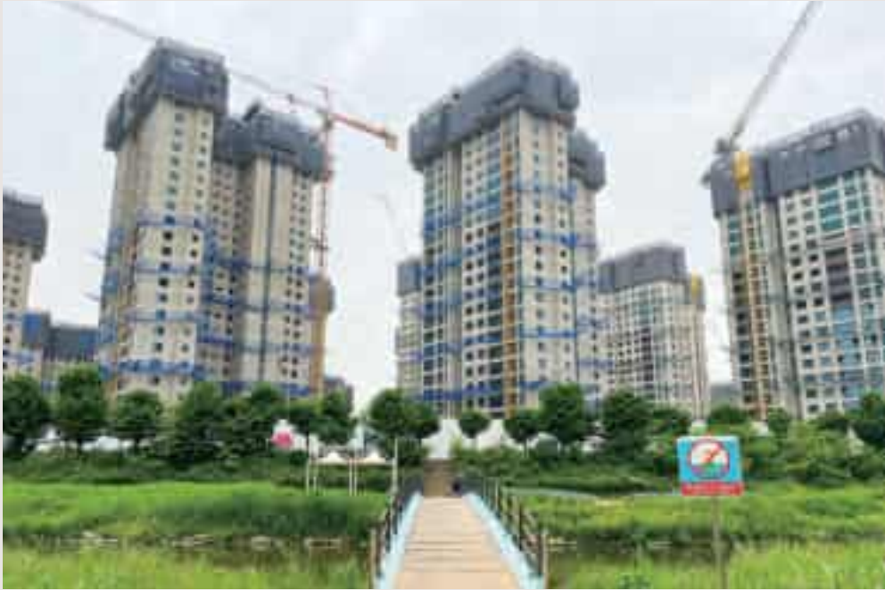
안양역푸르지오더샵 건설 현장(2023년 5월)
