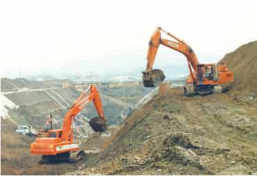
평촌신도시 내 공사 현장(1990)
