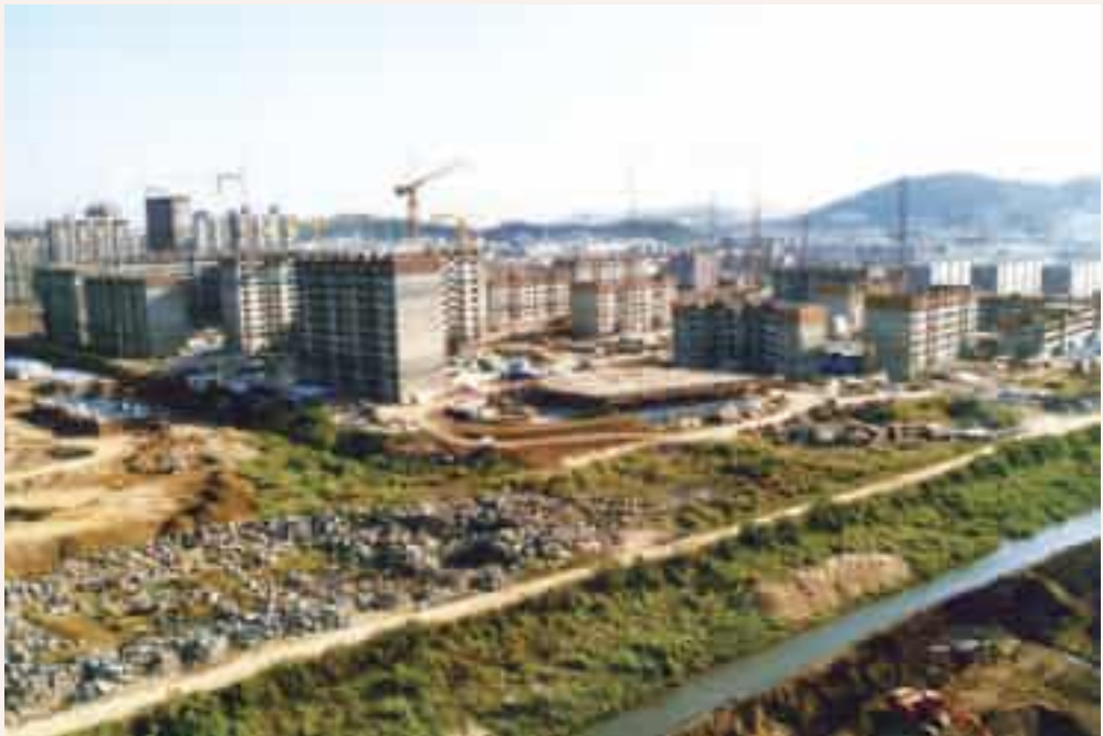
평촌신도시 조성 공사(1991)
