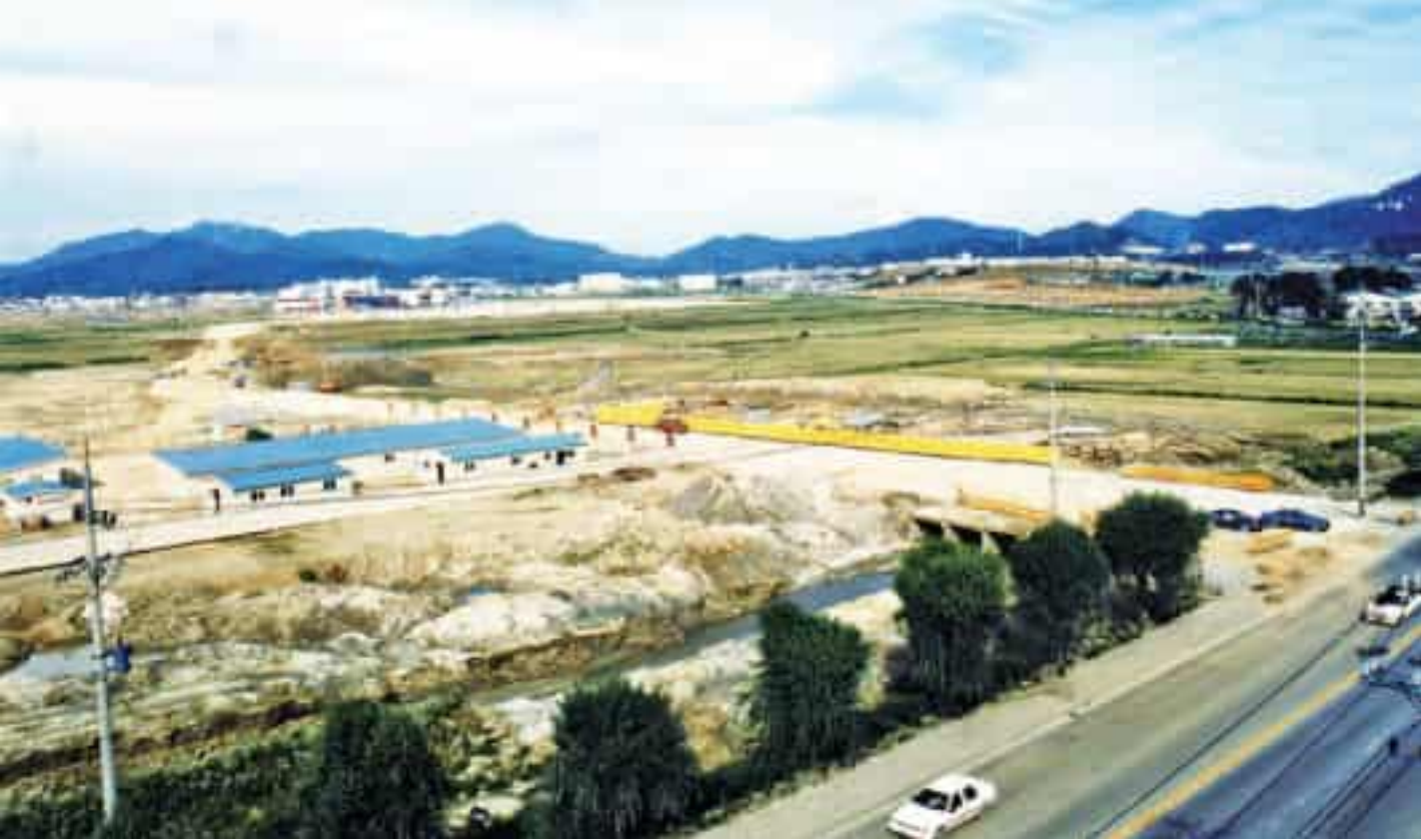
평촌신도시 조성 현장
