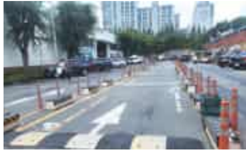
관련상품상가 앞 도로경계석(2024년 7월 말 기준)
