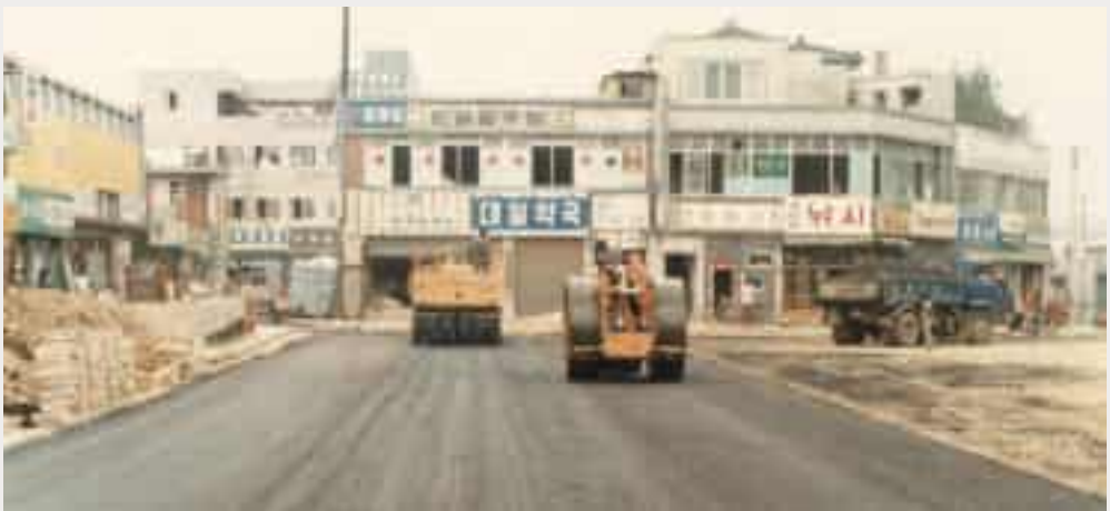
안양지하상가 공사 현장(1979~1981)
