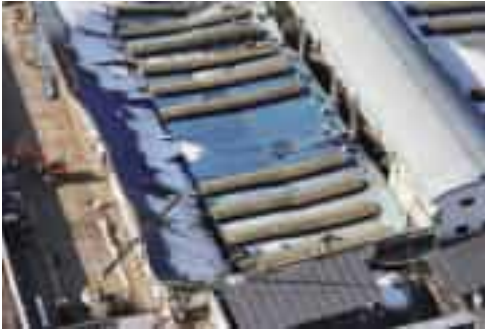
지붕 철거 작업 모습
