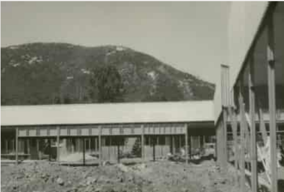
석수시장 건설 공사(석수유통 제공)
