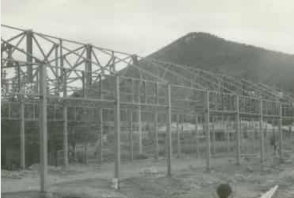
석수시장 건물 골조 공사(석수유통 제공)
