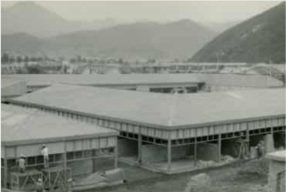
석수시장 건설 공사(석수유통 제공)
