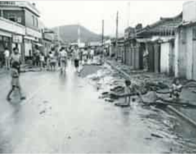
폭우로 파괴된 안양3동 주택가
