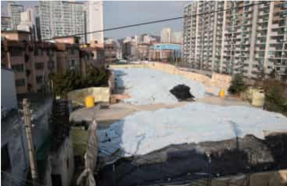
정보사령부 신설에 따른 진입로 건설공사(2015년, 안양시청 역사·포토갤러리 제공) 삼봉마을 일원 410m 구간이 정보사령부 진입로로 편입되었다.
