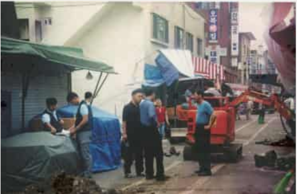
박달시장 통로 아케이드 설치 공사(2005년, 박달시장상인회 제공)
